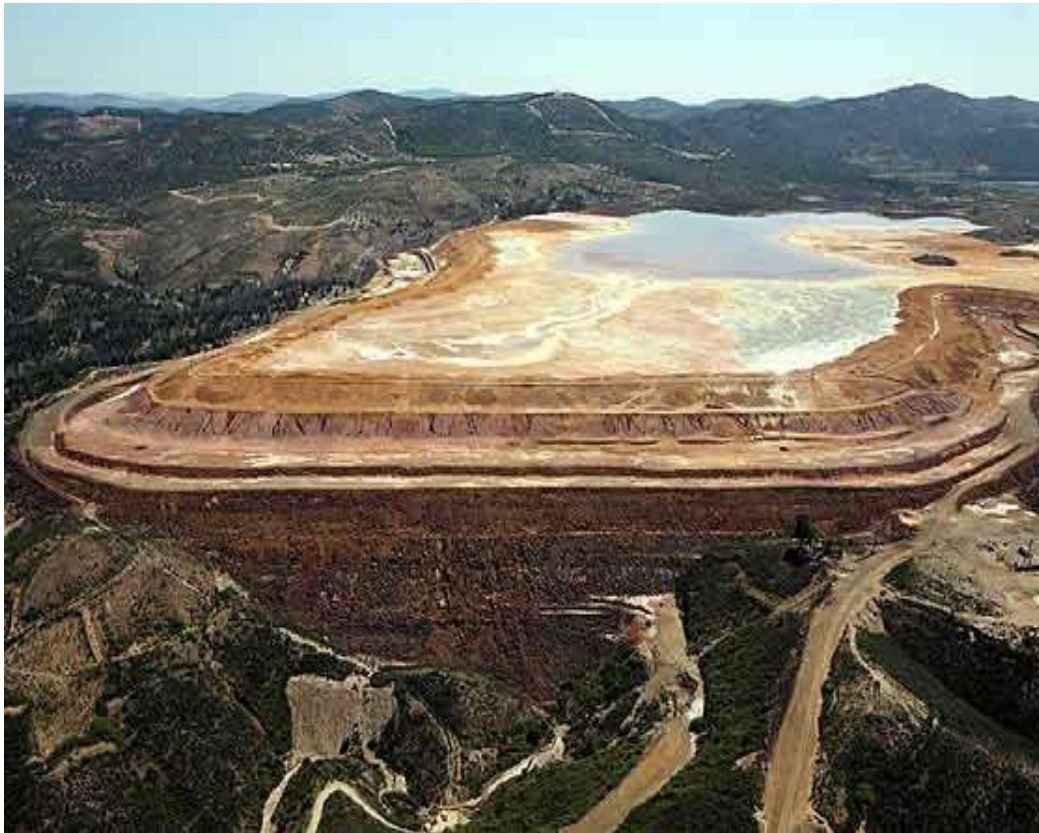
Recrecimiento de las presas de residuos mineros de la Mina Ríotinto
